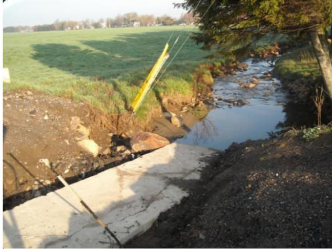
Figure 16: Ponceau effondré en amont de la station T-2 lors de la période d'échantillonnage
