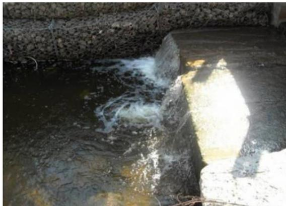
Figure 30: Seuil infranchissable pour les poissons
