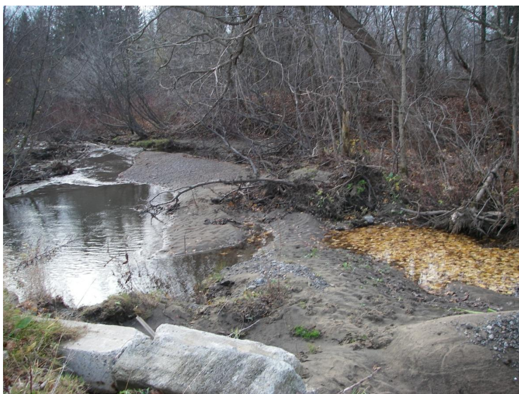
Photo 4 : Lessivage du chemin près de la station 05090049 Golf Métropolitain, vue vers l'aval - Octobre 2012
