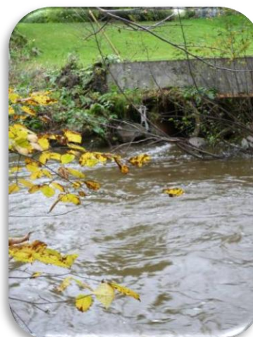
Photo 7.6 Émissaire d'eaux pluviales dans le tronçon TR-20
