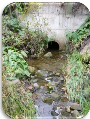
Photo 7.11 Émissaire d'eaux pluviales dans le tronçon TR-18
