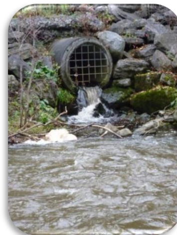
Photo 7.12 Émissaire d'eaux pluviales dans le tronçon TR-19
