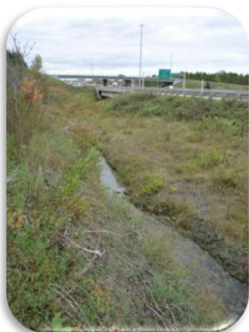
Photo 7.5 Fossé de drainage en bordure de l'autoroute 40
