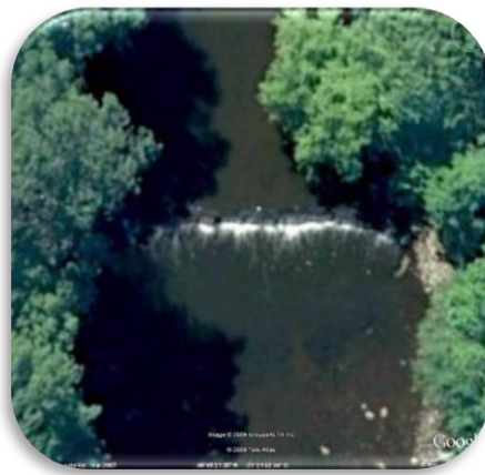
Photo 7.14 Image satellite du seuil situé près du boulevard de la Chaudière
