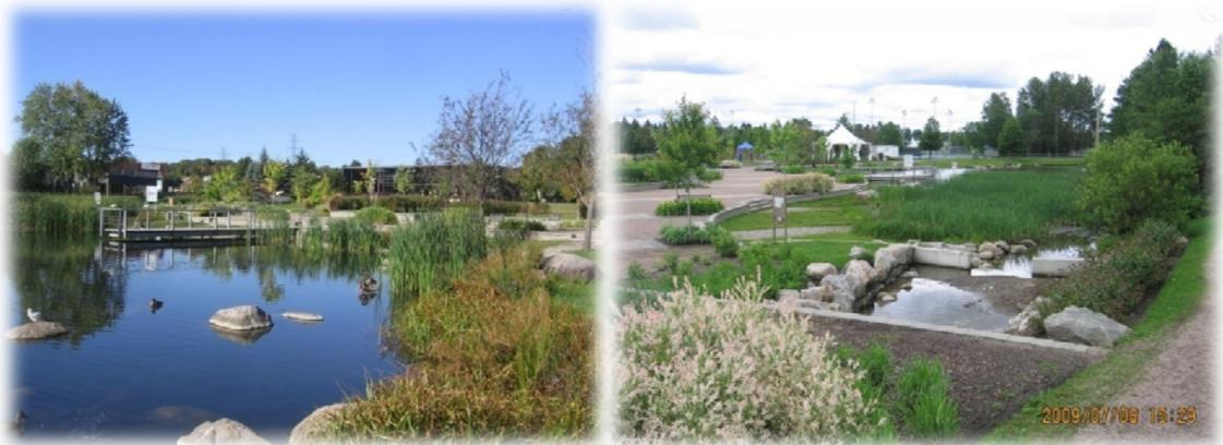
**Photo 5.4** Bassin de rétention des eaux pluviales aménagé dans une zone résidentielle, institutionnelle et commerciale au parc de la Chanterelle, boulevard Pie-XI Nord à Val-Bélair
