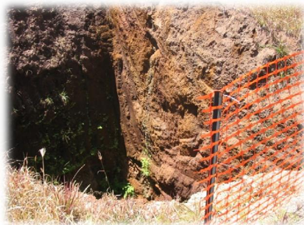
**Photo 5.3 Bassin de captation de sédiment dans une épingle en bordure d'une route non-pavée en terrain montagneux**
