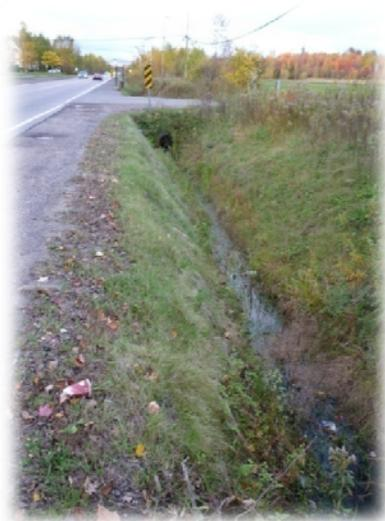
**Photo 5.2** Niveau d'exposition des talus de fossés de drainage urbain à l'érosion en fonction des saisons (4 avril et le 1<sup>er</sup> octobre 2009)
