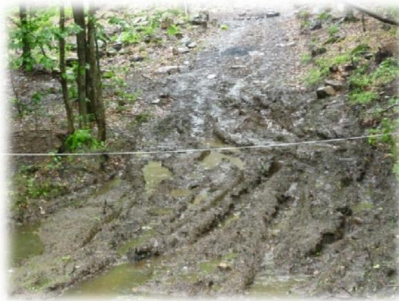
**Photo 3.7** Accès à un chantier de construction résidentiel sur l'avenue du Lac Saint-Charles montrant des signes évidents d'érosion (entrée privée) (4 juillet 2009)
