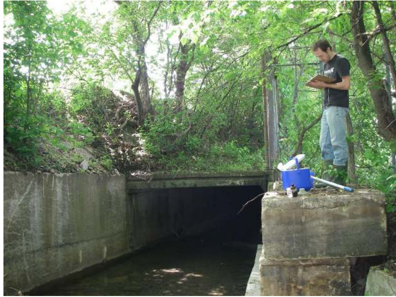
Figure 8. Station Loyola du Moulin, 10 juin 2013
