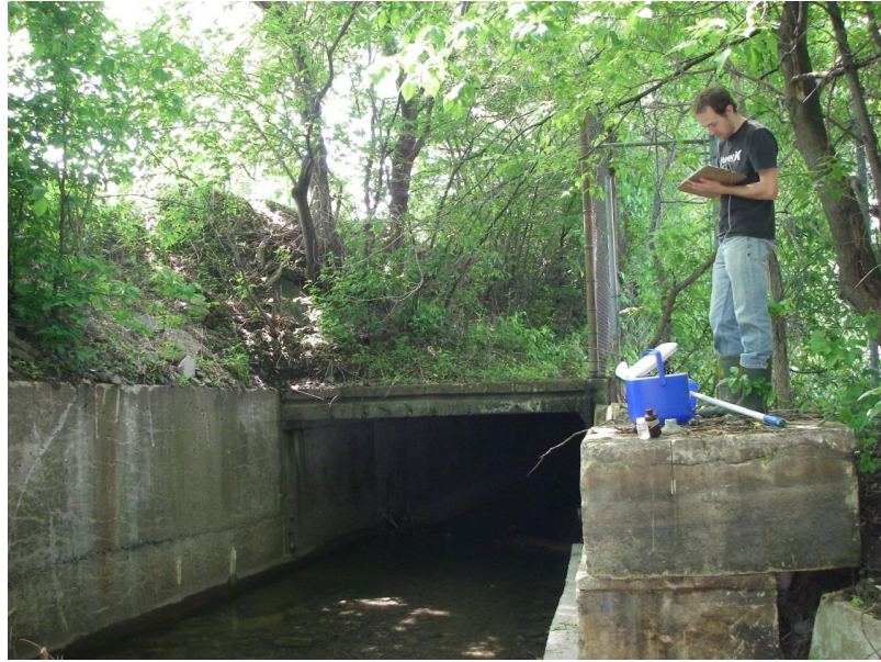
Figure 8. Station Loyola du Moulin, 10 juin 2013
