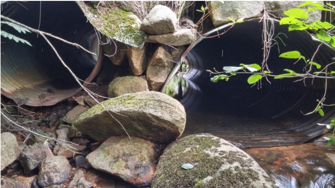
Figure 6: Ponceaux en amont de la station Waterloo #2 - Chemin du Moulin, 2018
