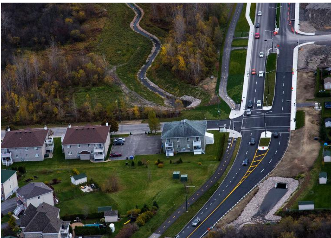
Figure 2: Détournement et canalisation du ruisseau Peuvret sous la rue Blanche-Lamontagne (Source : Génio Experts-Conseils, 2013)
