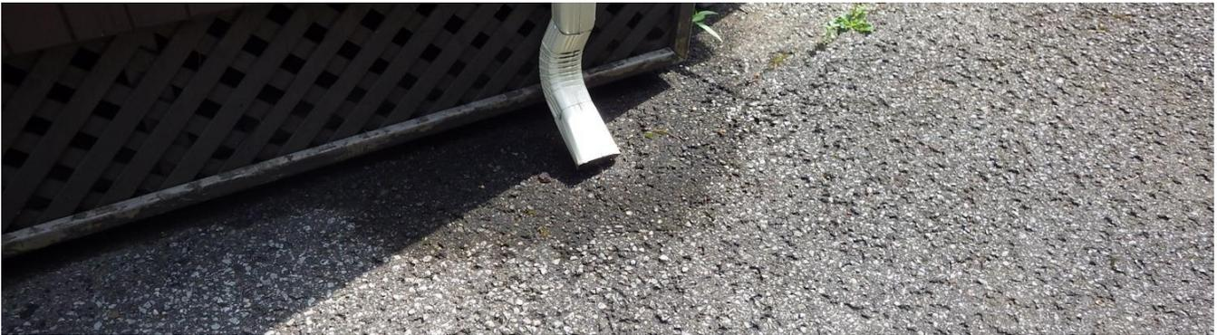
Figure 8. Exemple d'une gouttière nécessitant une correction
