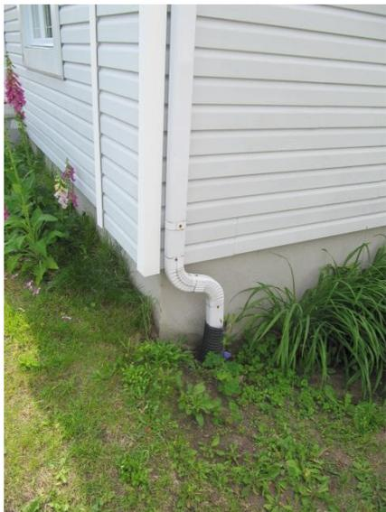
**Figure 28: Gouttière branchée au drain de fondation.**
