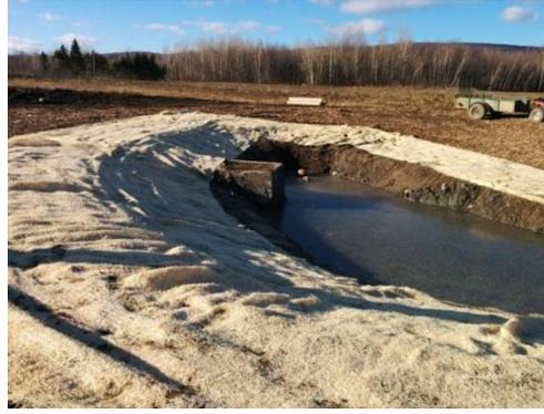
Figure 4: Travaux d'aménagement de la noue végétalisée (gauche) et du lac (droite) sur la ferme de Frédéric Rochon
