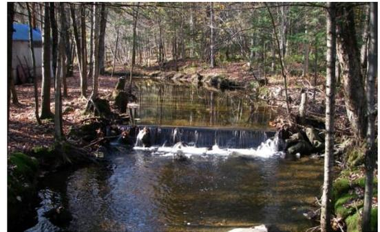
Figure 4 : Seuil en bois infranchissable par le poisson sur le ruisseau des Fiches.
