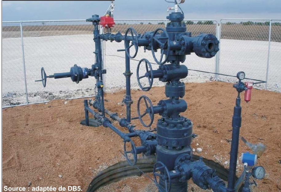
Figure 15.3 Tête de puits
