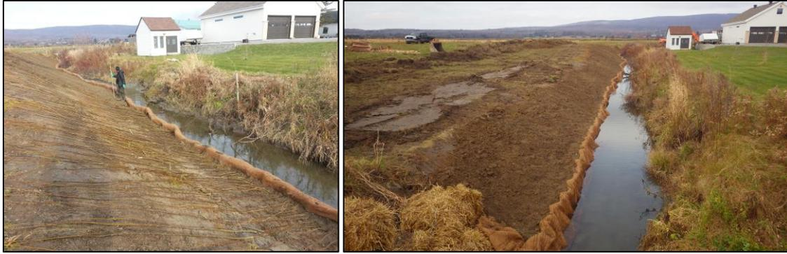
Photo 4: Profilage du talus et mise en place du lit de branches
