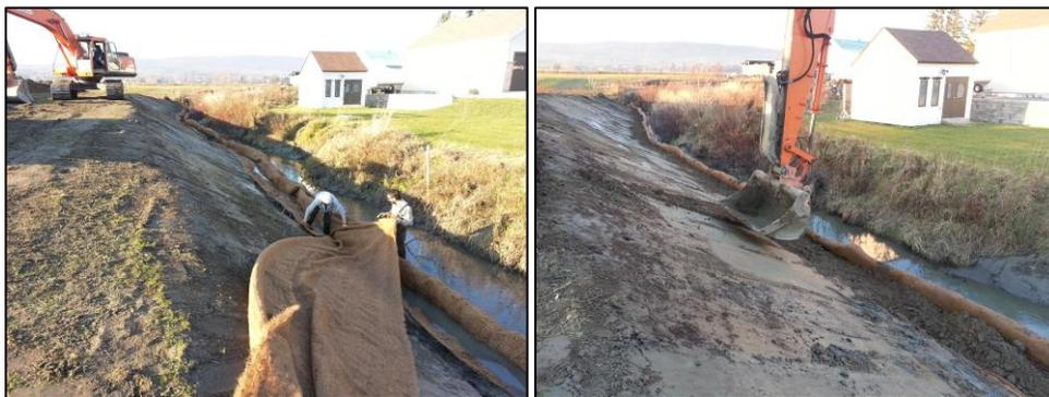
Photo 3 : Tressage des tiges de saules et remplissage de la gouttière
