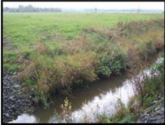
**Photo 3 : La bande riveraine laissée à l'état naturel près d'un ouvrage d'empierrement d'une sortie de drain**
