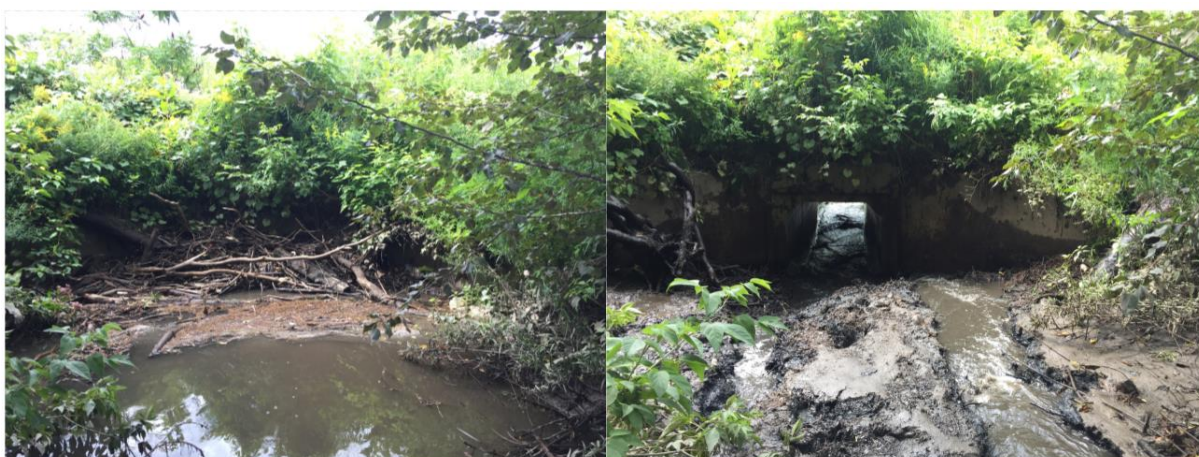
Figure 39 : Embâcle 3 (à gauche : avant le démantèlement; à droite après le démantèlement)
