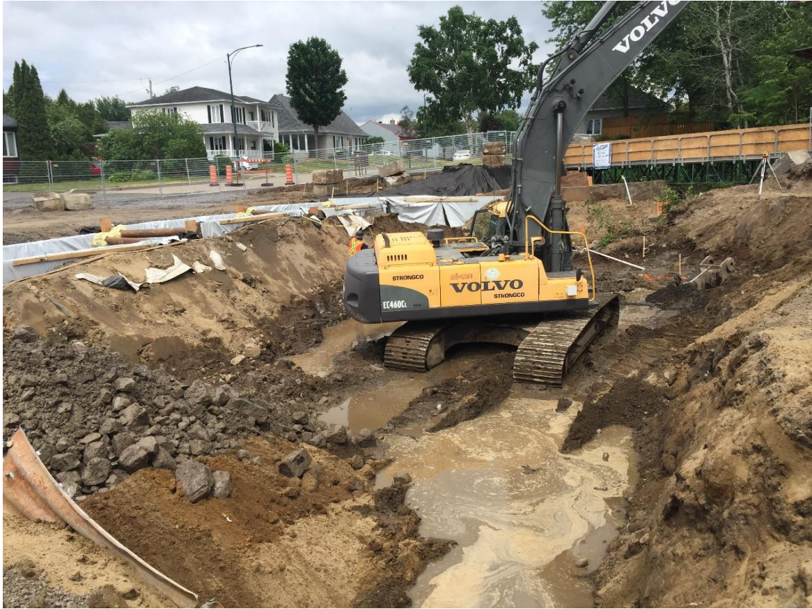
Figure 19 : Excavation du lit de la rivière Beauport au coin de la rue Naudet et du boulevard Louis-XIV
