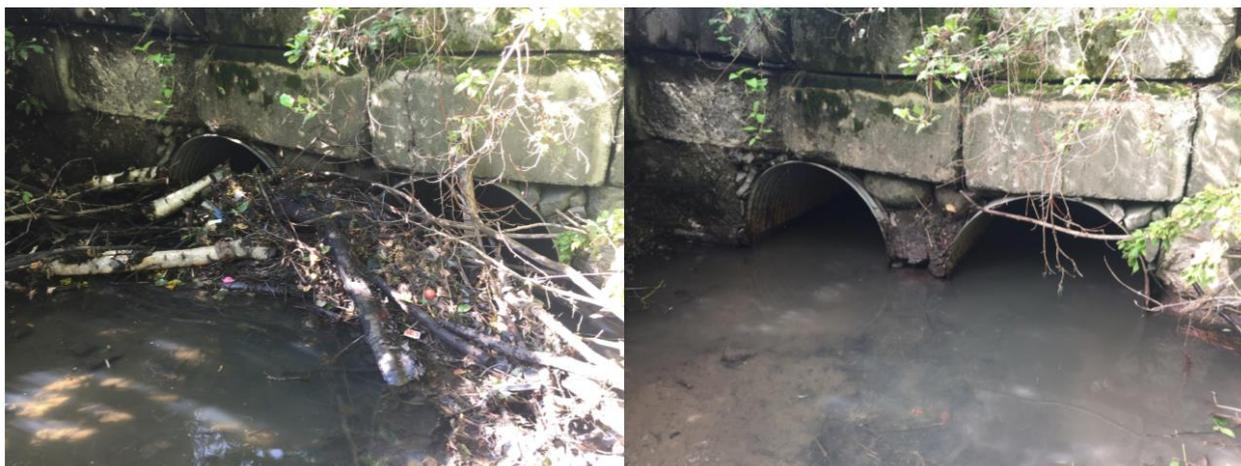
Figure 37 : Embâcle 1 (à gauche : avant le démantèlement; à droite après le démantèlement)
