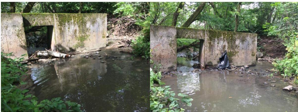
Figure 38 : Embâcle 2 (à gauche : avant le démantèlement; à droite après le démantèlement)
