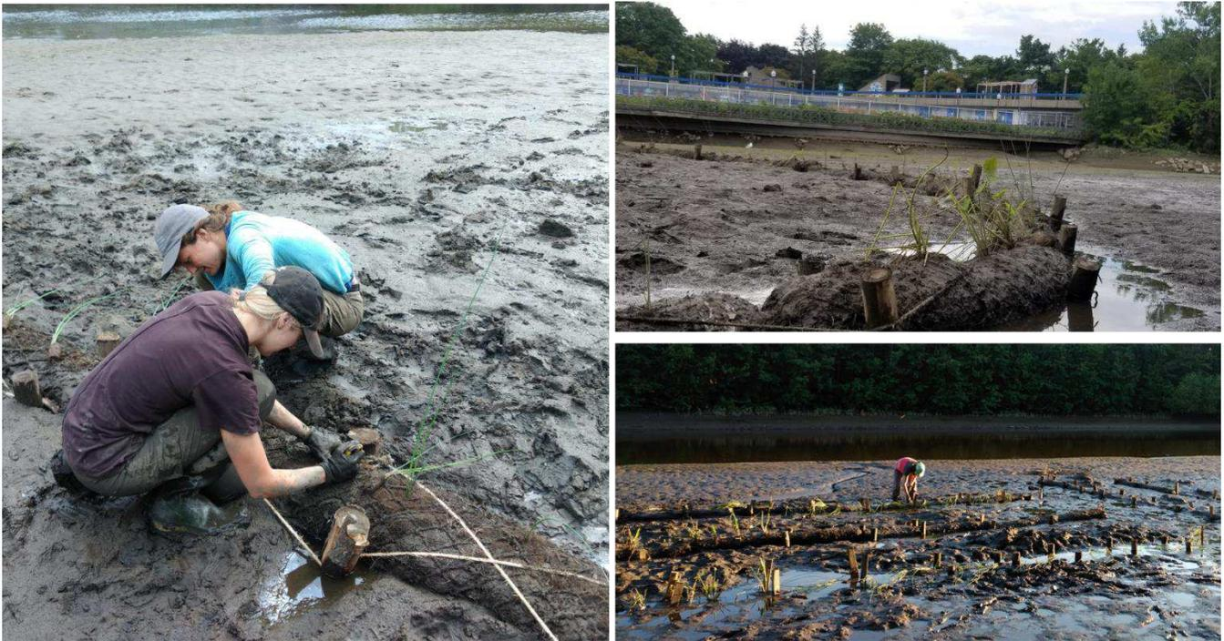
Figure 12 : Boudins de coco installés dans le sédiment et maintenus par des pieux de cèdre.
