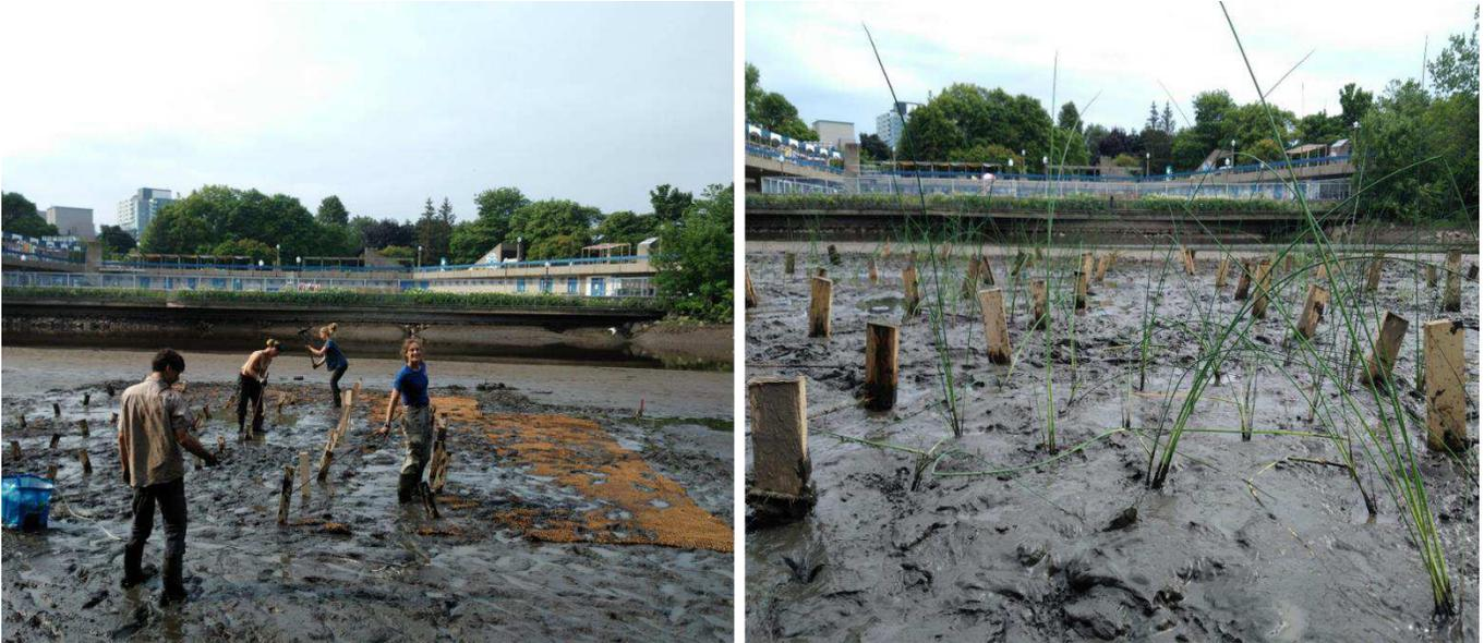
**Figure 13 : Installation du matelas de coco et stabilisation avec des piquets de bois. À droite : Scirpe d'Amérique planté dans le matelas de coco.**
