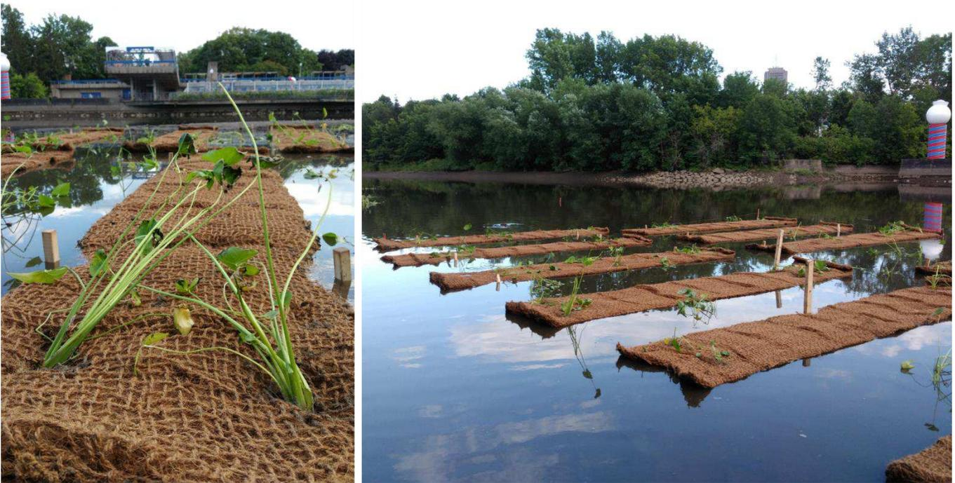
Figure 14 : Tapis de coco maintenus par des piquets de bois et de la corde.
