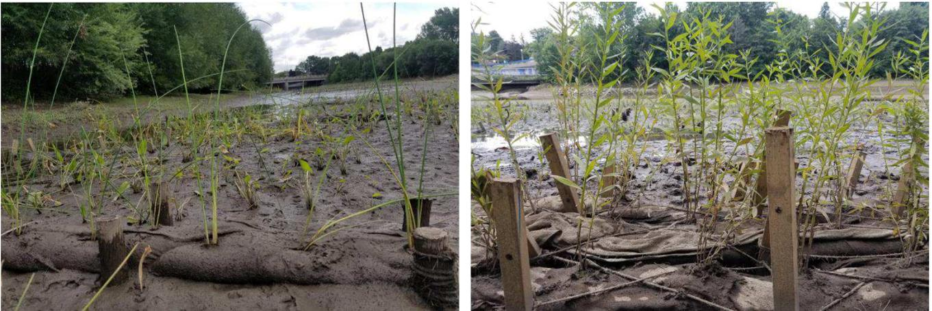
Figure 10 : Boudins de jute installés avec des piquets en bois ou des pieux de cèdre.
