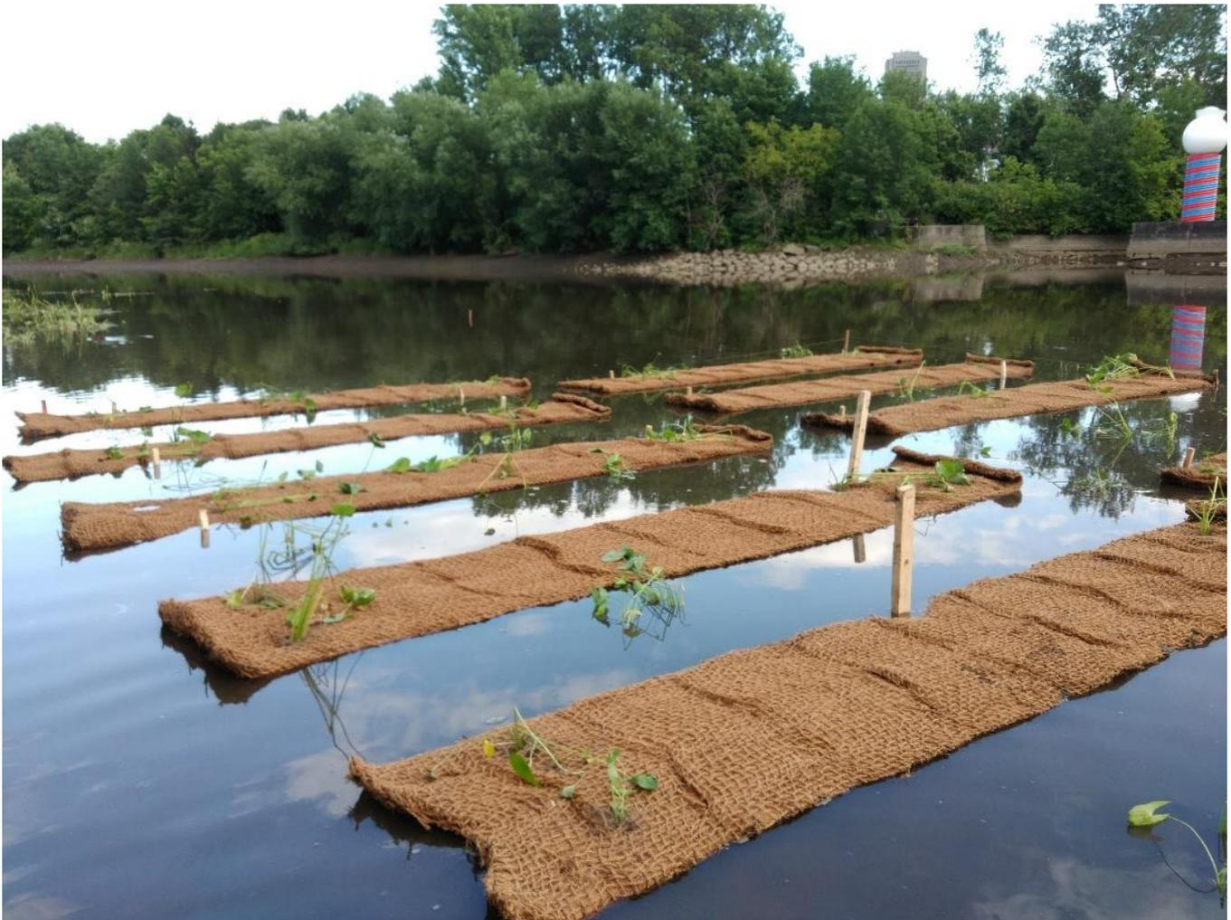
Figure 7 : Tapis de coco installés en marée montante sur l'îlot sableux.
