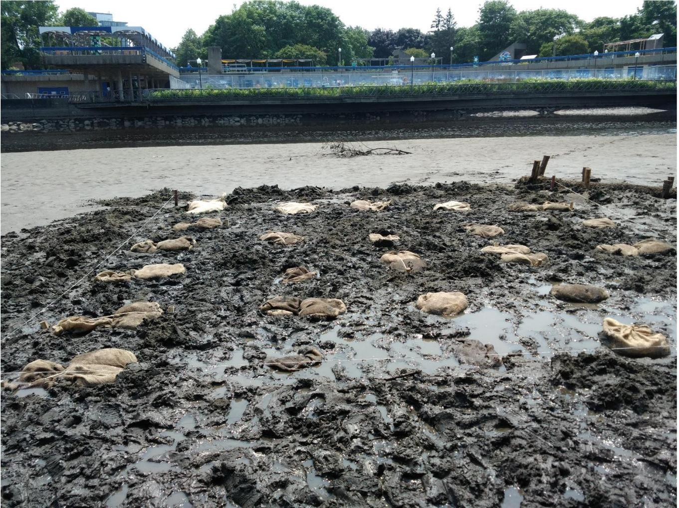
Figure 4 : Poches de jute installées sur l'îlot sableux.
