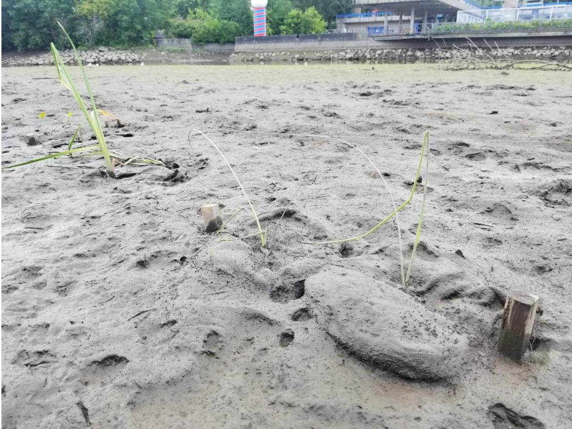
Figure 11: Poches de jute maintenues par des piquets de bois et de la corde.
