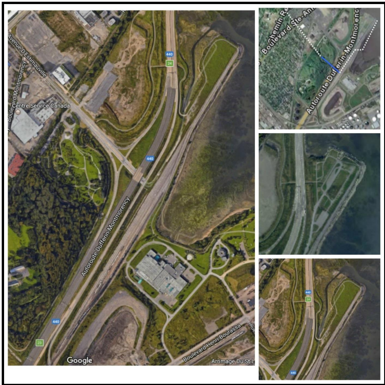
Figure 3: Décanalisation de l'embouchure du ruisseau du Moulin (Google satellite, 2017(gauche et en bas à droite); CAGEQ, 2009 (haut à droite); CMQ, 2008 (milieu à droite))
