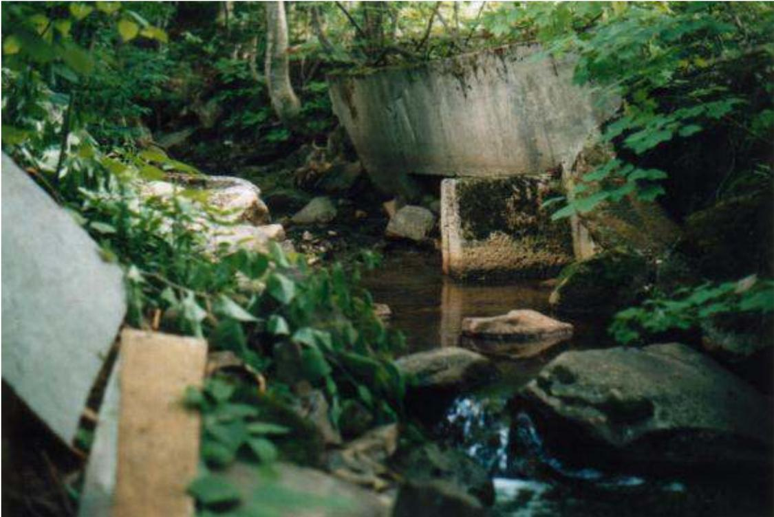
Figure 6. Muret désuet de blocs de béton causant de l'érosion dans le tributaire 3 du lac Beauport.
