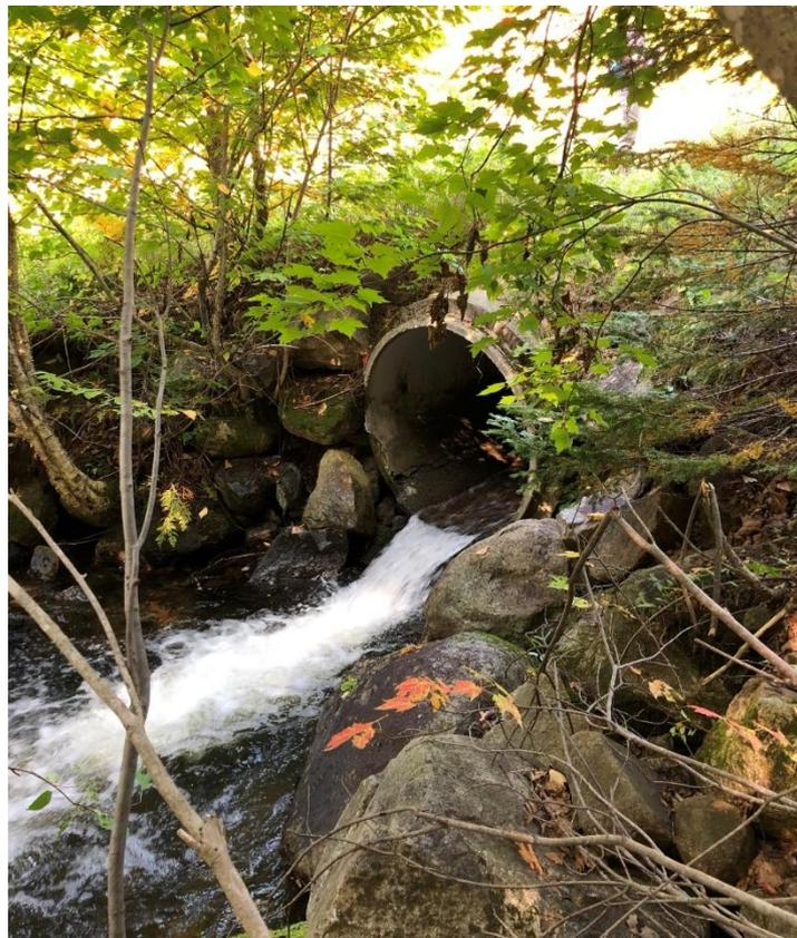
Figure 23 : Ponceau presque entièrement bouché par des débris (section 4)
