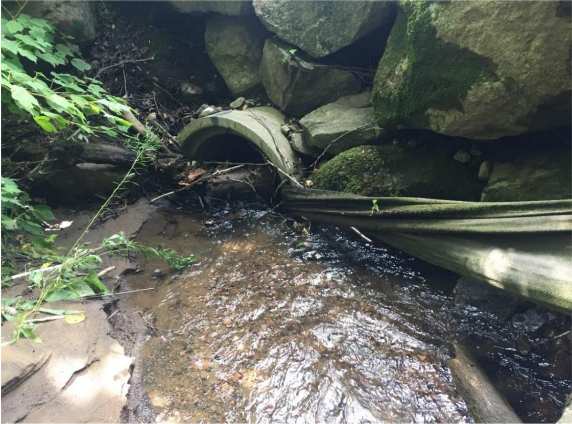
Figure 22 : Ponceau difficilement franchissable en raison de sa hauteur (section 6)
