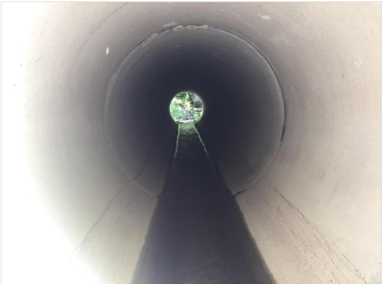
Figure 21 : Ponceau difficilement franchissable par le poisson (section 4)
