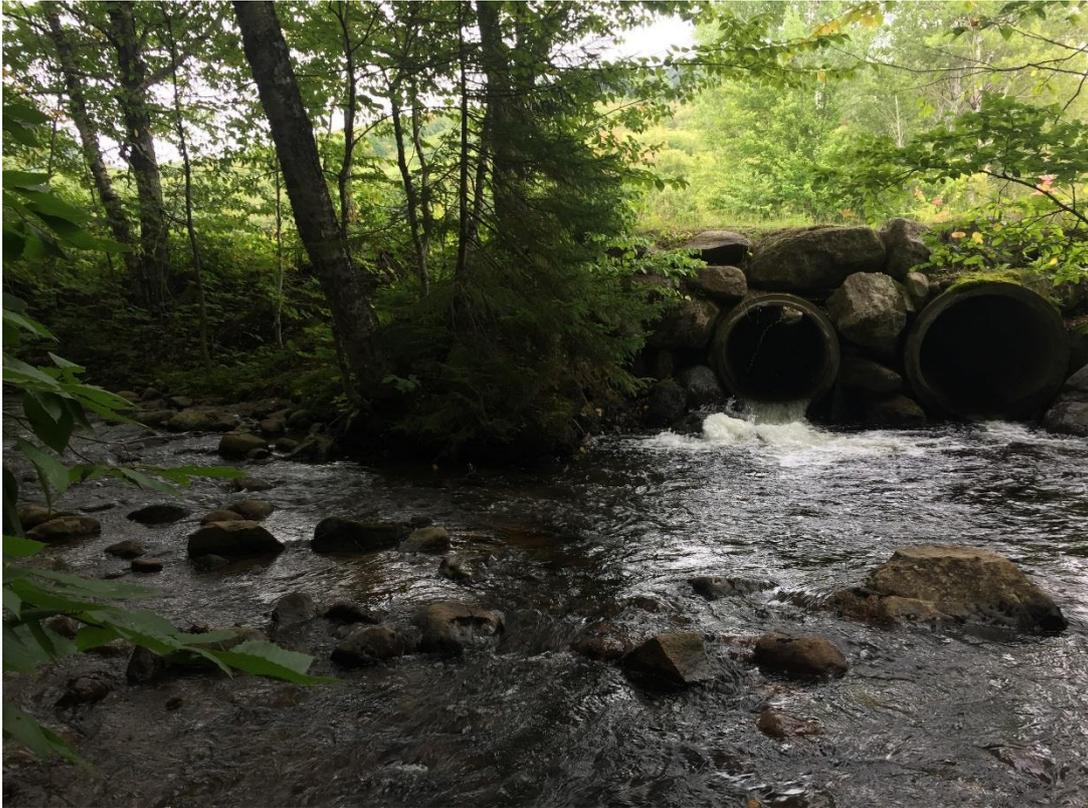
Figure 14 : Ponceau susceptible d'entraver le passage des poissons en raison de la hauteur (05-09-2019)
