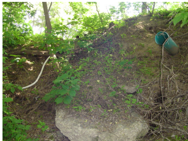
Figure 21. Drain de piscine se jetant dans le ruisseau du Moulin. (Crédit CAGEQ)
