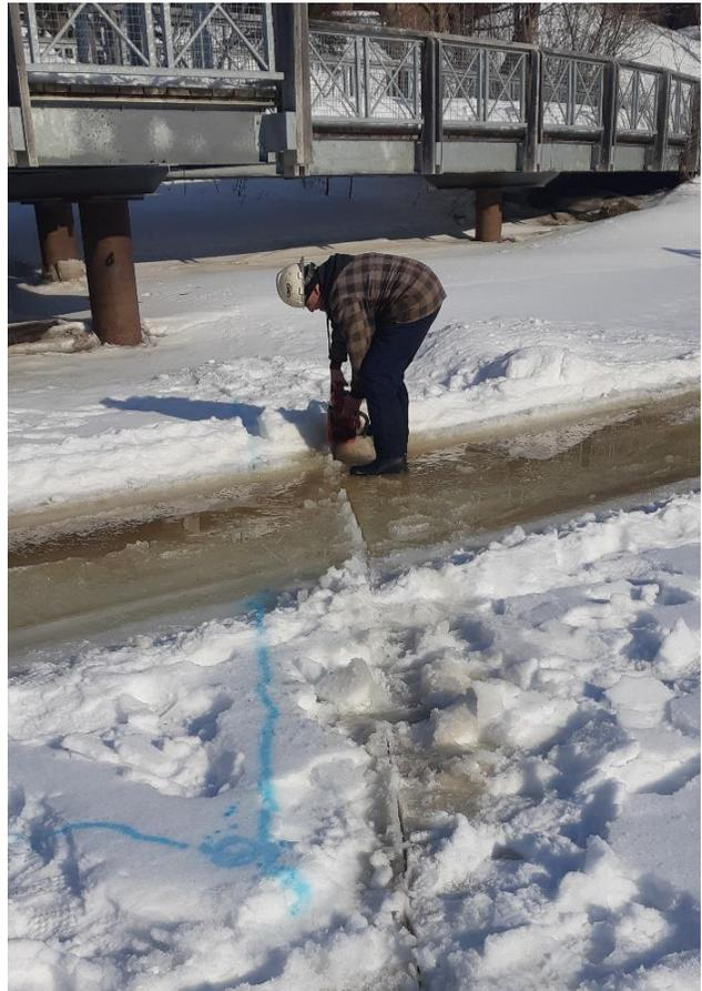
Figure 10 : À gauche : mesure de la glace pour en déterminer l'épaisseur ainsi que la hauteur d'eau. À droite : délimitation et sciage des zones d'insertion des pierres. OBV de la Capitale. 21 et 24 février 2020
