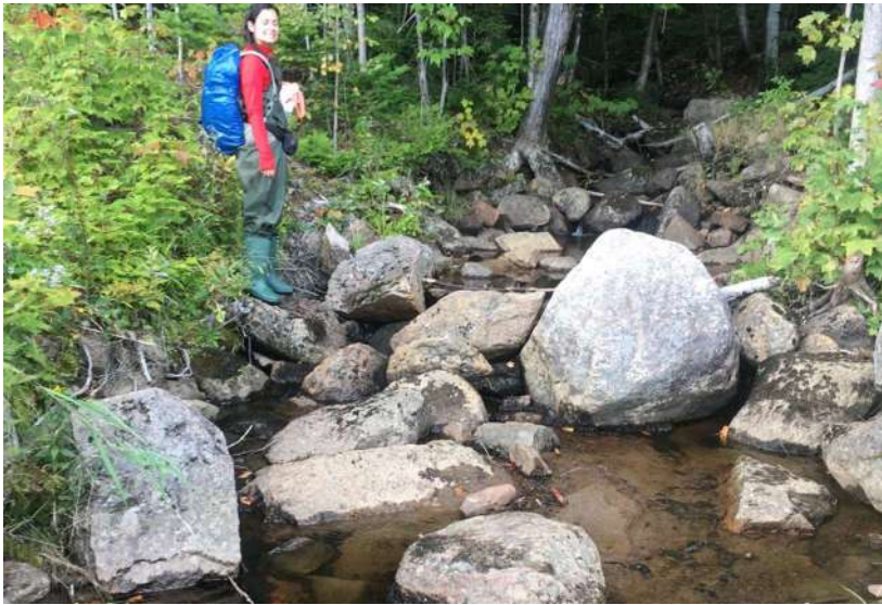
Figure 67. Se-h, Seuil à rendre franchissable en créant une échancrure vers la gauche, là où les blocs sont plus petits. Enlever les blocs au pied pour qu'une fosse se creuse.
