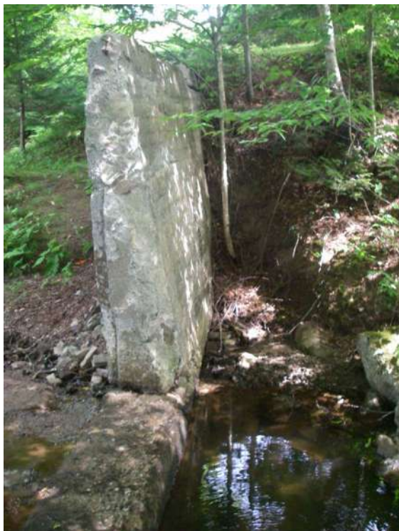
Figure 35. Au-3, Al-8 et Fo-7b : Ancien barrage Au-3 difficilement franchissable. Le seuil est d'une hauteur de 20 cm, et la fosse Fo-7b est présente en aval, mais il y a très peu d'eau en amont. Créer une échancrure permettrait à l'eau d'être canalisée à un seul endroit, ce qui créerait une chute franchissable. En amont, la faible profondeur d'eau crée une zone intéressante pour l'alevinage.
