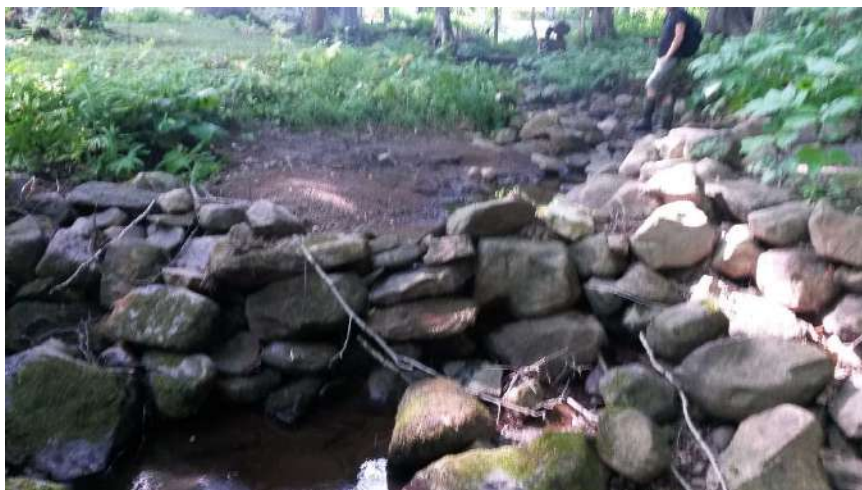
Figure 114. Sa-8, un seuil artificiel en blocs qui est infranchissable, qu'on pourrait rendre franchissable en l'abaissant et en lui créant une échancrure, en déplaçant les blocs.
