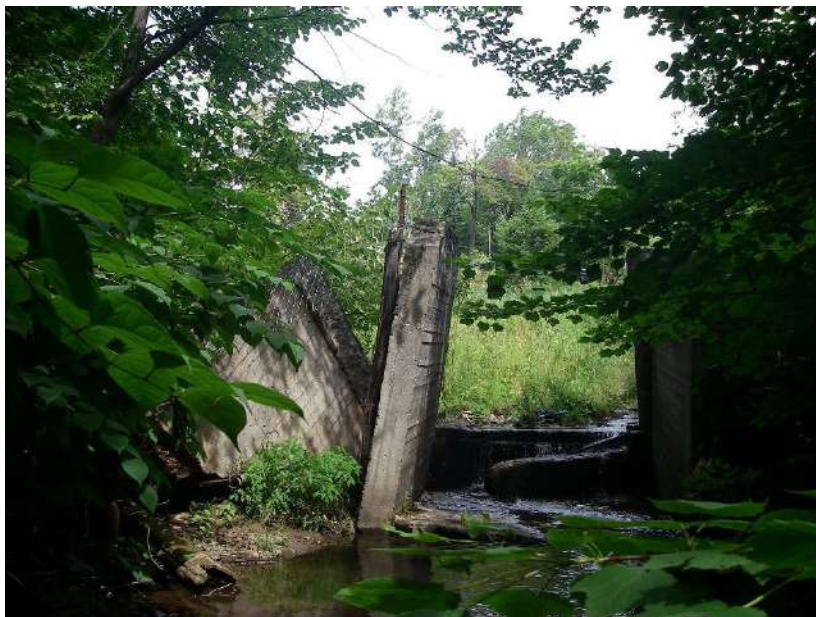
Figure 32. Ba1, Hauteur de la chute : 73 cm, bassin : 38 cm. Puisque le barrage ne retient plus beaucoup d'eau, le lac qu'il avait formé en amont a été envahi par la végétation et forme un petit milieu humide (photo de gauche).
