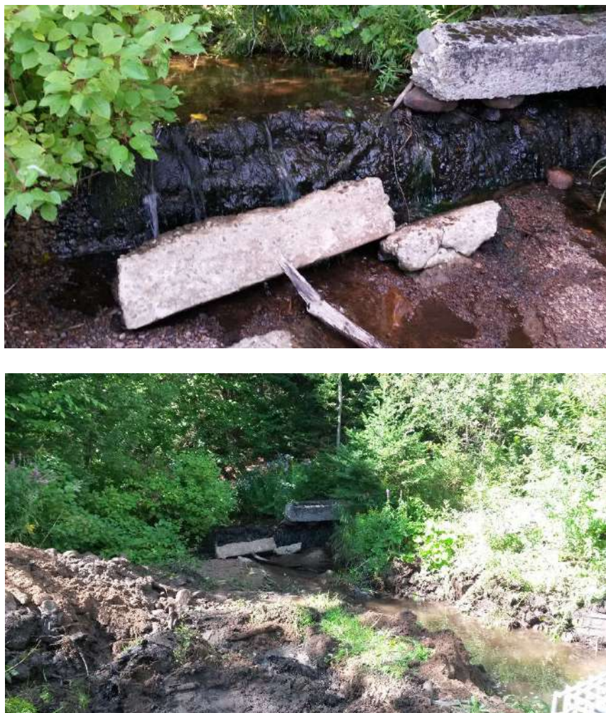
Figure 172. Ancien barrage Ba-4b, d'une hauteur de 1m. Droite : Ba4-b dans son contexte, avec un ponceau en aval (le grillage dans le coin).
