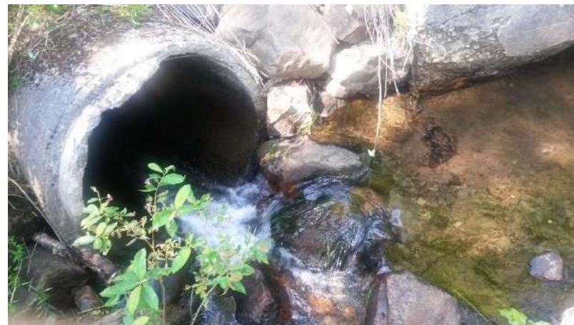
Figure 39. Au-4 et Pn-6: Ancien barrage Au-4 en béton créant un seuil de 43 cm de haut. Le rendre franchissable en créant une échancrure dans le béton, enlevant le bois au pied et creusant une fosse au pied. Le ponceau Pn-6 est juste en aval de ce barrage et est dans un angle très prononcé. Il est aussi trop étroit, ce qui crée un courant de 113 cm/s, trop rapide pour les ombles de fontaine de moins de 125 mm de longueur.
