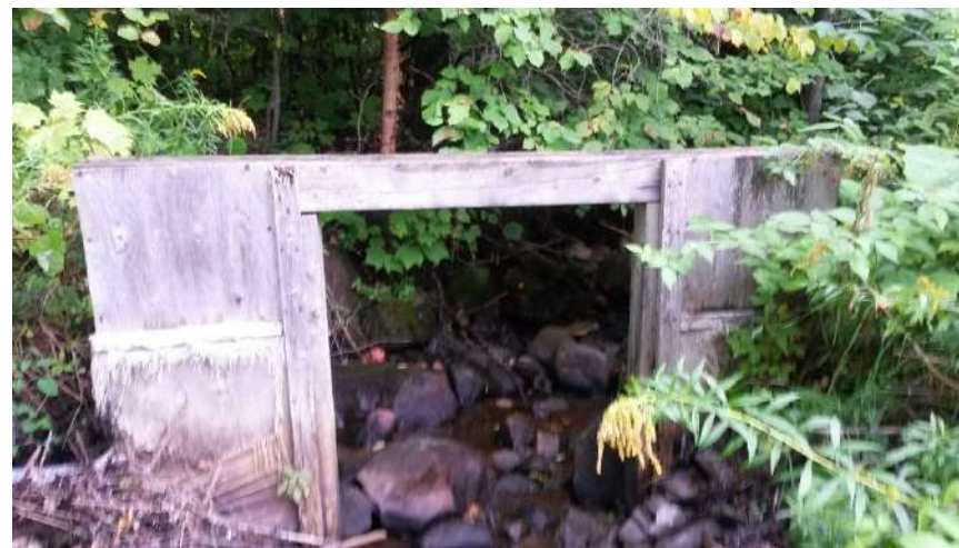
Figure 124. Lac formé par le barrage Ba-9, qui explique l'assèchement du ruisseau en aval. Le barrage semble franchissable lorsqu'il y a plus d'eau. Il serait intéressant de l'abaisser.
