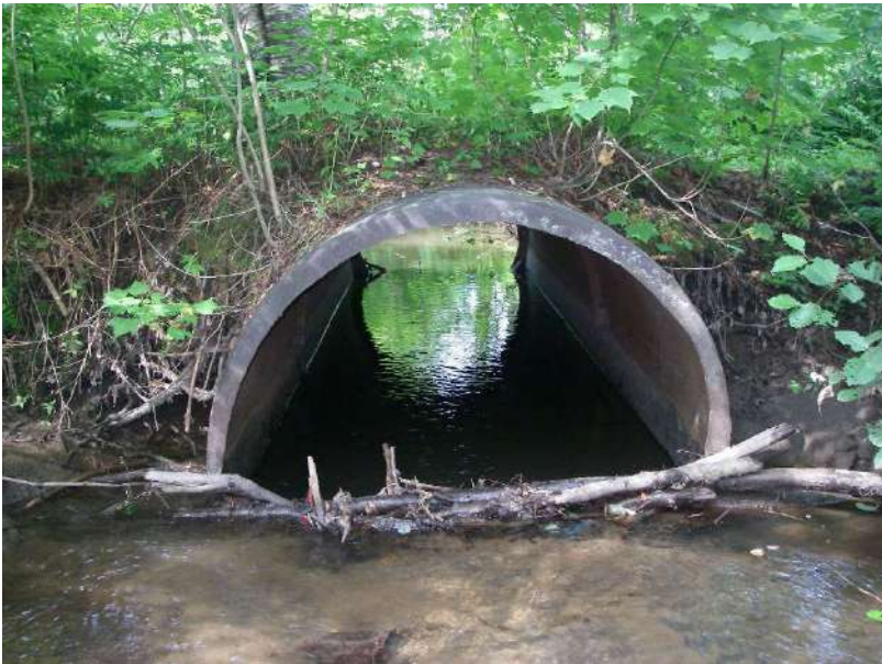
Figure 21. Ponceau Pn-4, avec un petit embâcle en amont, à démanteler afin d'accélérer le courant sur la frayère Fr-4 située très près, en amont.
