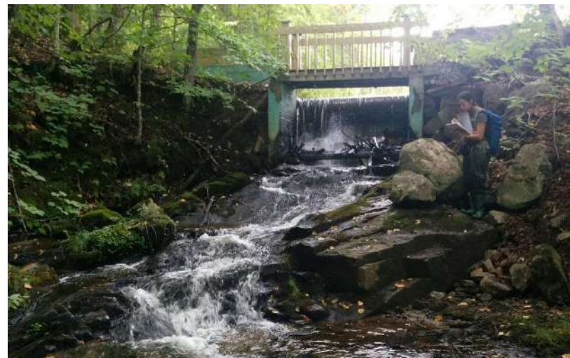
Figure 46. Ca-1, Ca-a et Ba-3. À gauche, cascade Ca-1, et barrage Ba-3 au loin. À droite, cascade Ca-a et barrage Ba-3. L'ensemble de ces éléments est très difficile à franchir pour l'omble de fontaine, mais retirer les planches du barrage pourrait aider.
