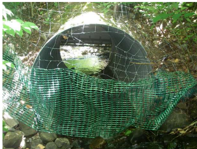
Figure 37. Ponceau Pn-5, avec une clôture en plastique : le petit espace libre dans le bas est probablement suffisant pour permettre le passage de l'omble de fontaine. Outre la clôture, le ponceau est franchissable.
