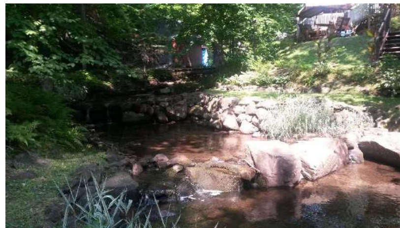
Figure 42. Pl-6, Pn-7 et Sa-3 : Le ponceau Pn-7 avec des planches en amont, qui retiennent un grand bassin, suivi de deux seuils en blocs qui forment un autre bassin. Les abords sont à végétaliser.
