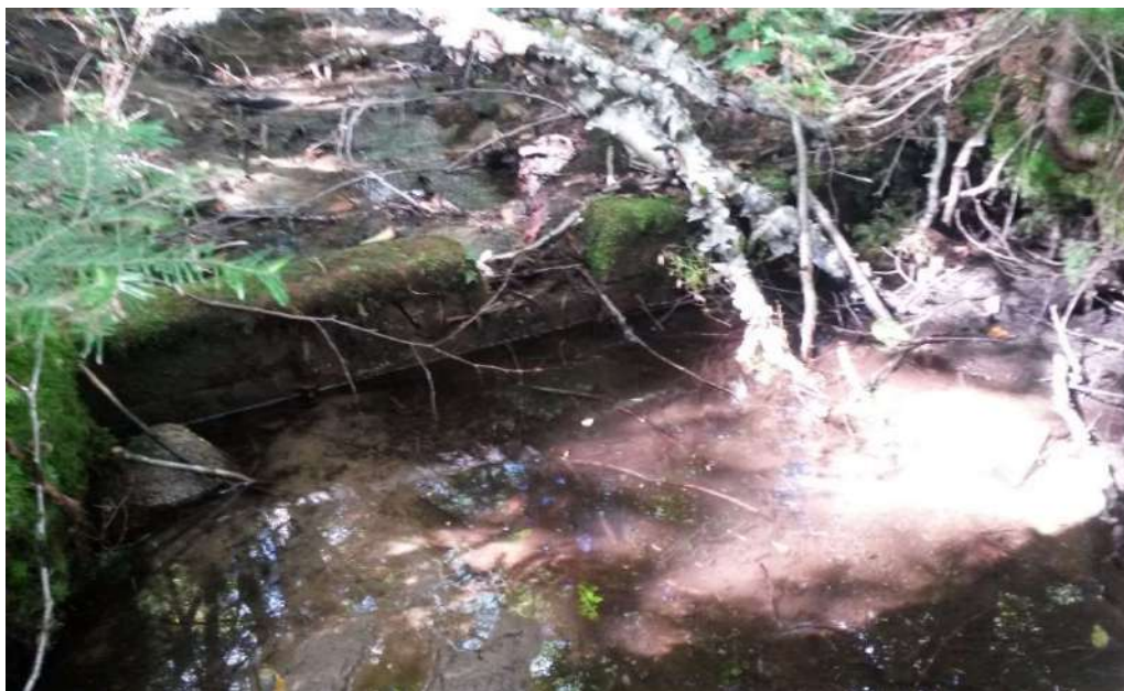
Figure 85. Sa-10, le seuil aménagé par le Conseil de bassin de la rivière Beauport. Gauche : État actuel, Lorsque le niveau d'eau est plus élevé, le seuil contribue probablement à creuser la fosse na aval. Droite : État original, en 2005.
