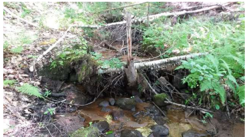
Figure 141. Embâcle Em-7, infranchissable.
