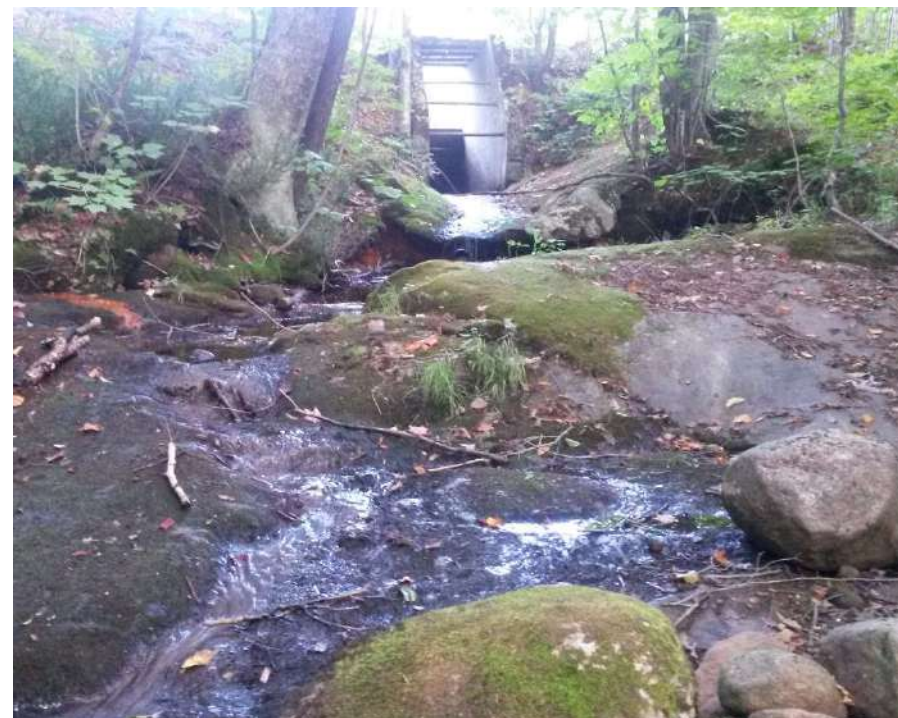
Figure 74. Ba-7a, le barrage qui retient le lac Caché. Il est complètement infranchissable, à cause du radier de béton de plusieurs mètres, de la marche d'environ 50 cm de hauteur et des planches. Il y a peu d'espoir de rendre cet obstacle franchissable.
