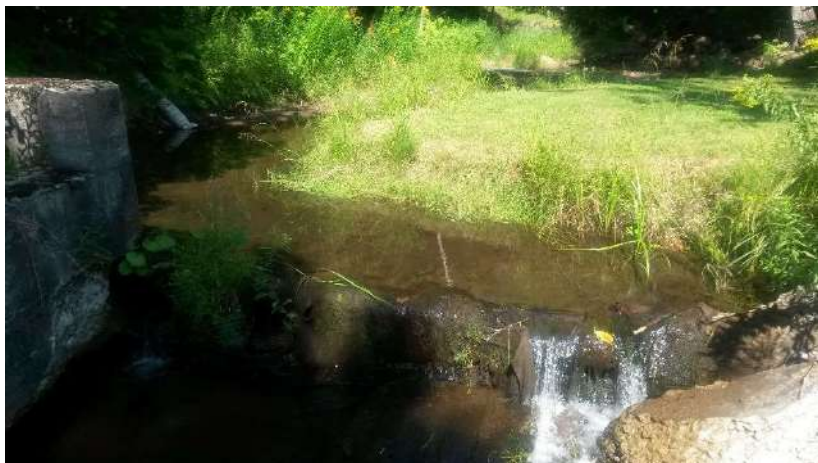
Figure 39. Au-4 et Pn-6: Ancien barrage Au-4 en béton créant un seuil de 43 cm de haut. Le rendre franchissable en créant une échancrure dans le béton, enlevant le bois au pied et creusant une fosse au pied. Le ponceau Pn-6 est juste en aval de ce barrage et est dans un angle très prononcé. Il est aussi trop étroit, ce qui crée un courant de 113 cm/s, trop rapide pour les ombles de fontaine de moins de 125 mm de longueur.
