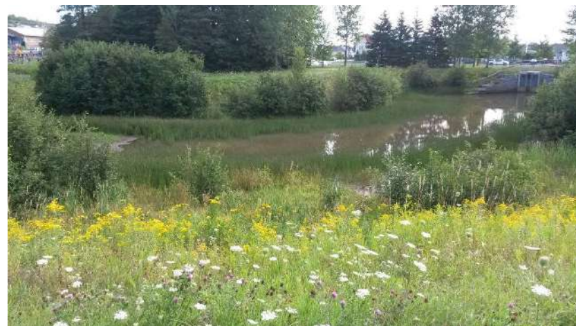
Figure 136. Bassin de rétention en aval du segment.
