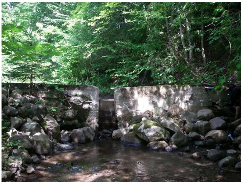
Ba-2 : Barrage complètement infranchissable. Le sable se serait accumulé en un seul été, selon le propriétaire, qui dit avoir installé les planches en juin 2016. Retirer les planches progressivement afin d'éliminer progressivement le sable accumulé.
