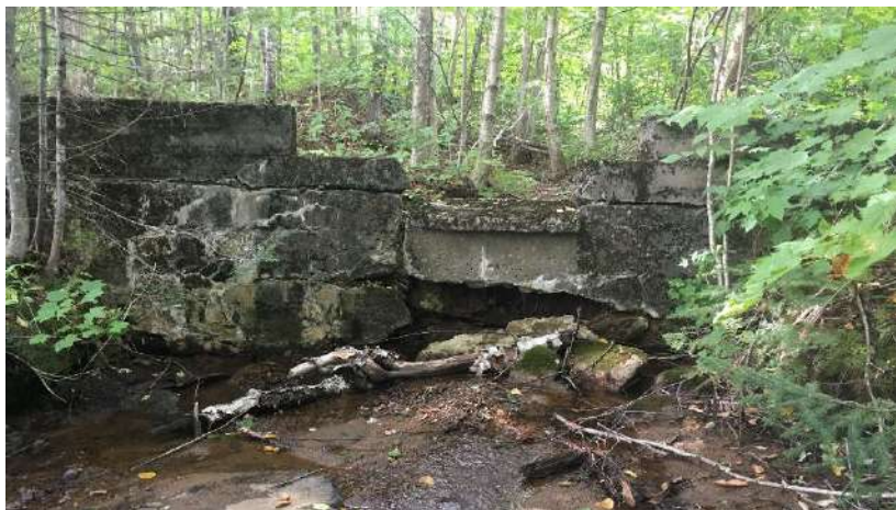
Figure 73. Au-9, un ancien barrage infranchissable. Il faudrait retirer la partie de béton du milieu, qui est la moins épaisse, afin que le cours d'eau reprenne un cours plus naturel.
