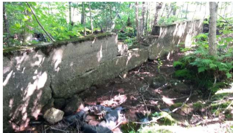
Figure 73. Au-9, un ancien barrage infranchissable. Il faudrait retirer la partie de béton du milieu, qui est la moins épaisse, afin que le cours d'eau reprenne un cours plus naturel.
