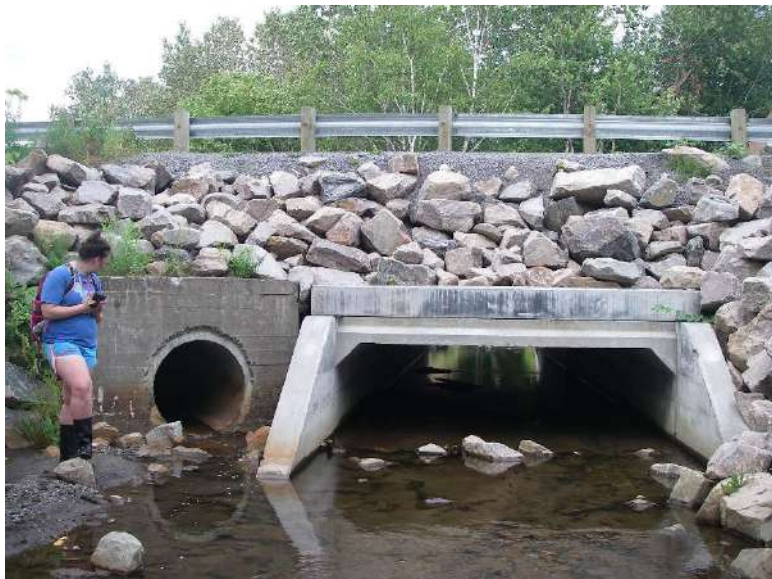
Figure 15. Pt2 et sa conduite pluviale, à la traversée de la rue de l'Alaska.
