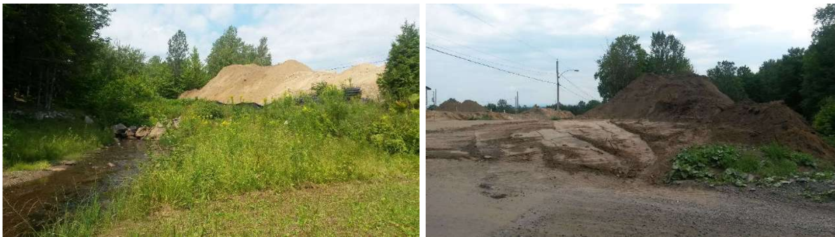
Figure 47. Co-1, Développement immobilier près de la fin du segment, qui pourrait apporter beaucoup de matières en suspension et de sable dans la rivière.
