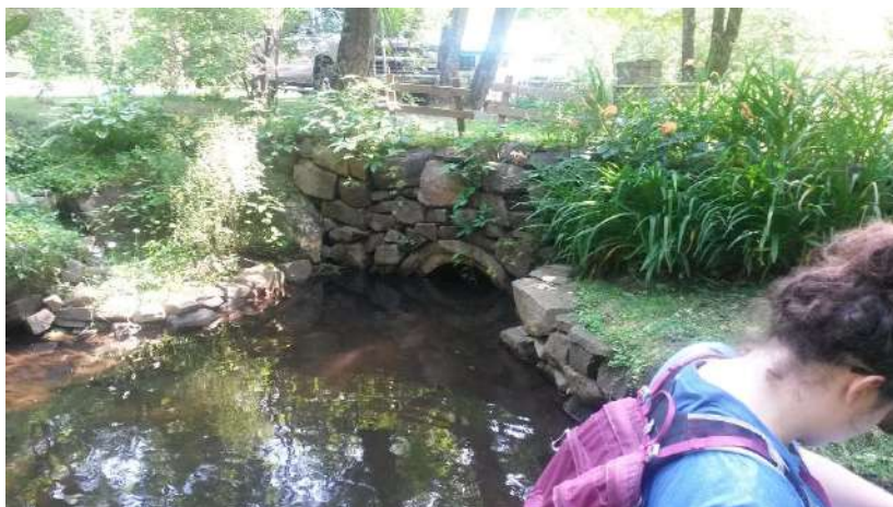
Figure 42. Pl-6, Pn-7 et Sa-3 : Le ponceau Pn-7 avec des planches en amont, qui retiennent un grand bassin, suivi de deux seuils en blocs qui forment un autre bassin. Les abords sont à végétaliser.
