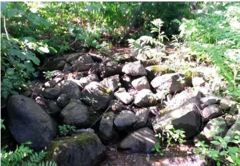
Figure 151. Seuil en blocs (Se-11) d'environ 1 m de hauteur. Il faudrait y créer un chenal au centre afin de concentrer l'écoulement de l'eau, ce qui le rendrait franchissable par l'omble de fontaine.
