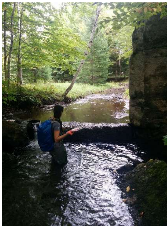
Figure 35. Au-3, Al-8 et Fo-7b : Ancien barrage Au-3 difficilement franchissable. Le seuil est d'une hauteur de 20 cm, et la fosse Fo-7b est présente en aval, mais il y a très peu d'eau en amont. Créer une échancrure permettrait à l'eau d'être canalisée à un seul endroit, ce qui créerait une chute franchissable. En amont, la faible profondeur d'eau crée une zone intéressante pour l'alevinage.
