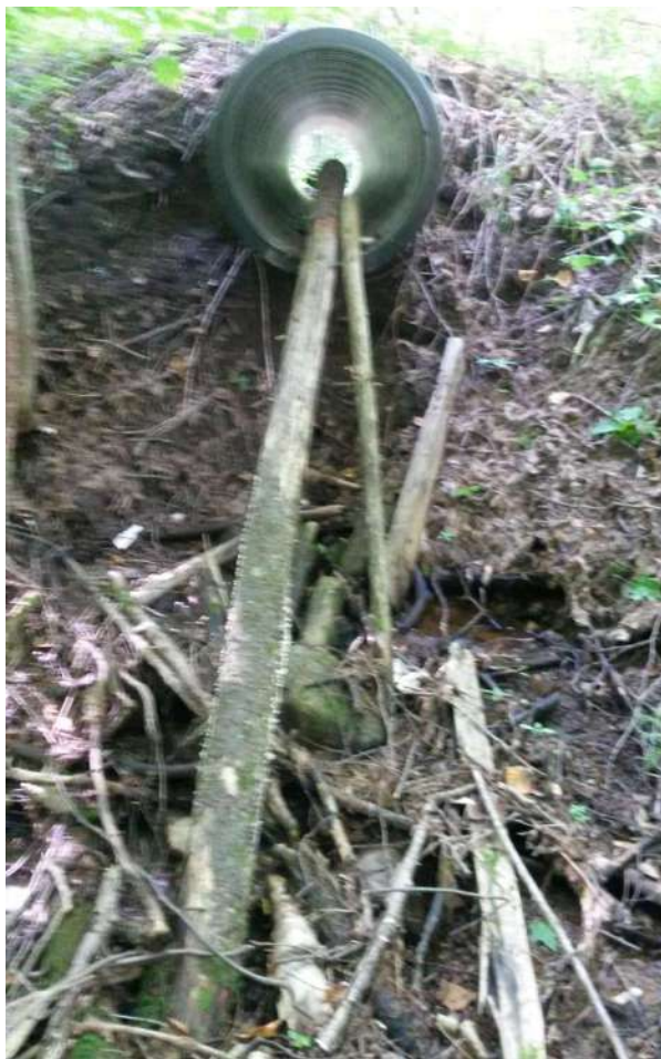
Figure 149. Pn-27, avec une hauteur de 1,1m : infranchissable, et ne laisse pas passer l'eau, ce qui assèche le cours d'eau en aval.
