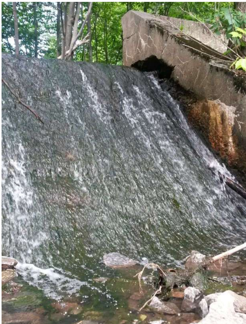
Au-6 : Barrage actif de 3 m de haut, presque vertical. Il est à 4 m en amont d'un ponceau, et forme un grand bassin de 12 m de diamètre en amont.
