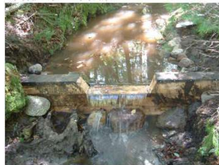
Figure 85. Sa-10, le seuil aménagé par le Conseil de bassin de la rivière Beauport. Gauche : État actuel, Lorsque le niveau d'eau est plus élevé, le seuil contribue probablement à creuser la fosse na aval. Droite : État original, en 2005.
