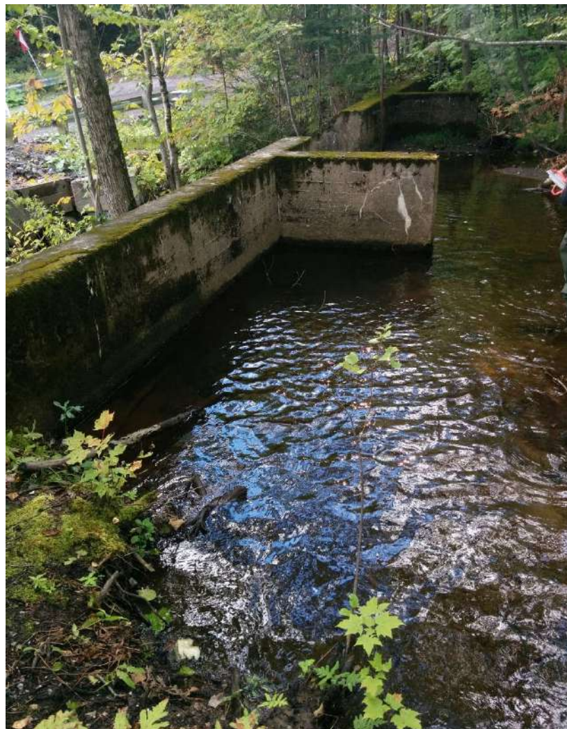
Au-6 : Barrage actif de 3 m de haut, presque vertical. Il est à 4 m en amont d'un ponceau, et forme un grand bassin de 12 m de diamètre en amont.
